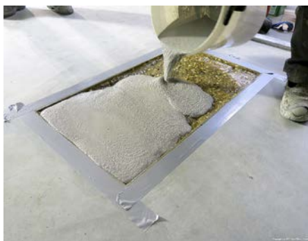
(5) Instandsetzung Einzel-Schadstelle: Reprofilierung mit Reaktionsharzmörtel
