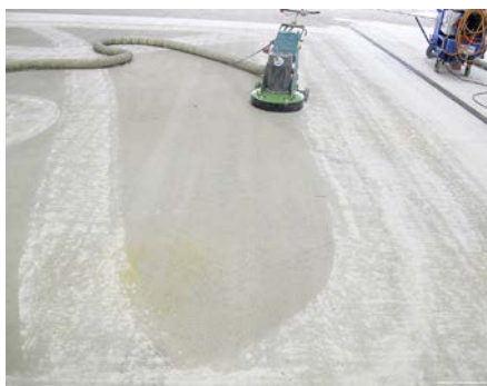
(6) Verbesserung/Optimierung einer Industriebodenoberfläche mittels maschinellen Schleifen zur Reduzierung der Rauheit
