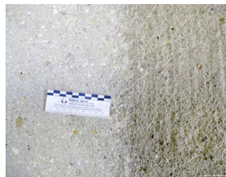
(7) Nahaufnahme unterschiedlicher Rauheiten: linke Teilfläche nach erfolgtem maschinellen Schleifen
