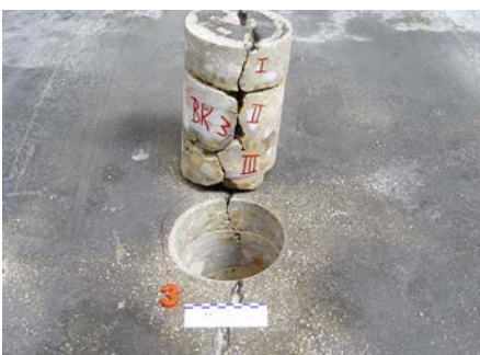
(2) Bohrkernentnahme/Sondierungsbohrung, die z. B. den Schichtaufbau und vorhandene Risse zeigt
