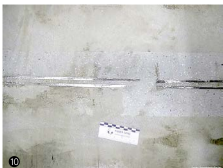
(8 bis 11) Durch Fahrbeanspruchung mit Flurförderzeugen verursachte Schäden an einem Stahlfugenprofil
