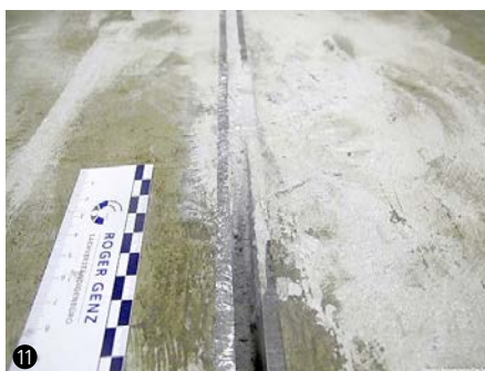
(8 bis 11) Durch Fahrbeanspruchung mit Flurförderzeugen verursachte Schäden an einem Stahlfugenprofil
