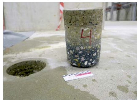
(1) Bohrkern mit Estrichschicht: Randzone mit Übergang Beton und Estrichschicht von etwa 45 mm Dicke
