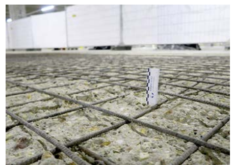
(4) Industriebodenoberfläche aus Stahlbeton nach Abtrag der Betonrandzone durch Hochdruckwasser- und Feststoffstrahlen
