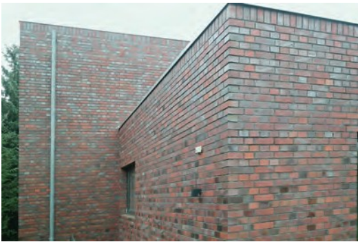
Bild 1. Verblendmauerwerk in der Struktur eines „Blockverbands“ mit Fertigstürzen (Foto: Gigla)
