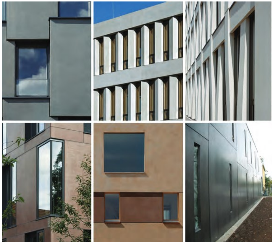
Abb. 7.1 Fassaden aus Architekturbeton (Fotos: FDB-Mitgliedsunternehmen).
